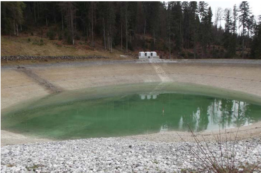
Speicherteich Kandahar (Foto: B. Wimmer)
