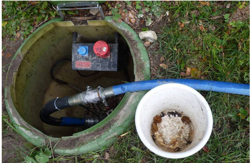
Plastik-Schneischacht mit Amphibien (Foto: B. Wimmer)
